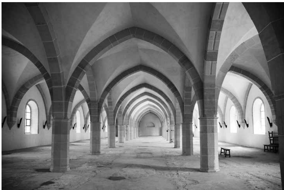
Gerestaureerd dormitorium in het gebouw van de conversen. © foto: Harry van Royen.
